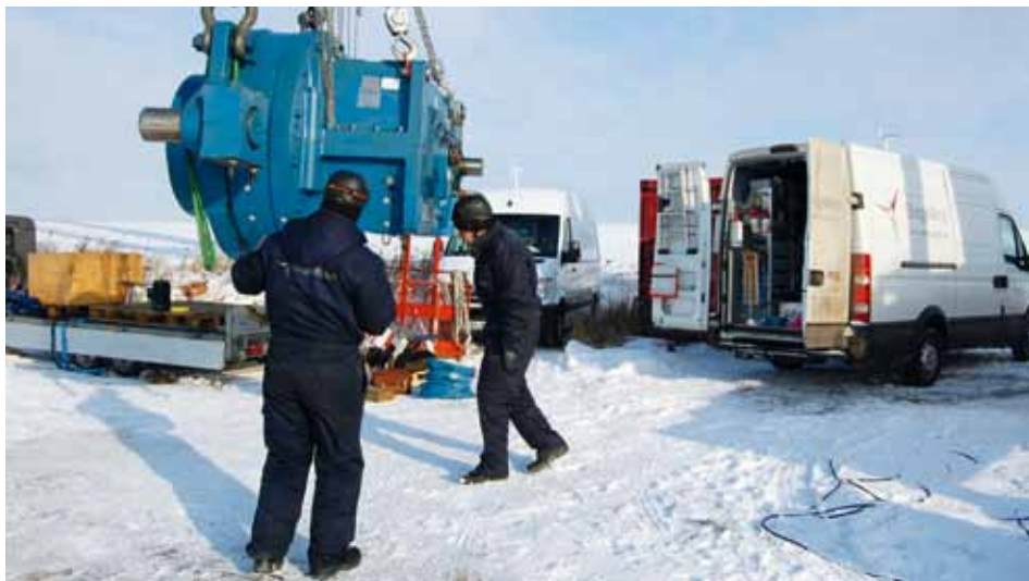
Tausch eines Nordex N 60 Getriebes in Sachsen-Anhalt durch StiegeWind.
